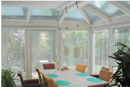
Isolierglas (Dicke ca. 58mm) produziert werden. Die Alu-Lamellen haben eine Breite von 16 mm und sind in verschiedenen Farben herstellbar. Auch große Glasflächen können gefertigt werden und erlauben gestalterische Freiheit. ISO-Shadow und ISO-Roll lassen sich dabei in nahezu alle Rahmensysteme ob Alu, Holz, Kunststoff oder Stahl integrieren.
