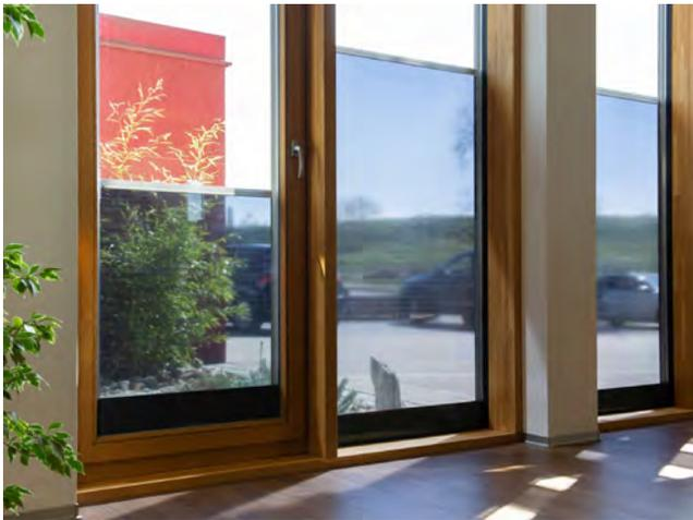
Abb. 3 – Die Rollos sind elektrisch bedienbar, stufenlos positionierbar und werden einzeln oder in Gruppen angesteuert
