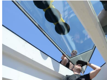
Abb.3: Reibungsloser Einbau der maßgefertigten Verglasung
