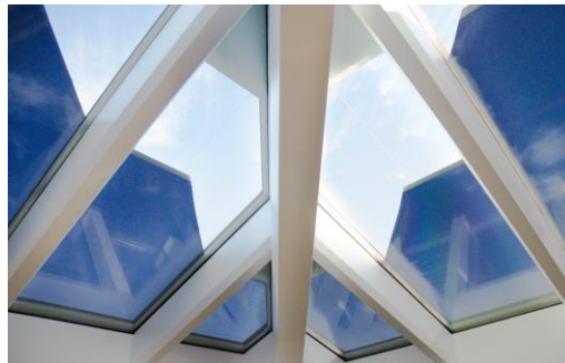
Abb.4: ISO-Roll: Mit zwei Motoren von unten nach oben auch bei Eckverglasungen
