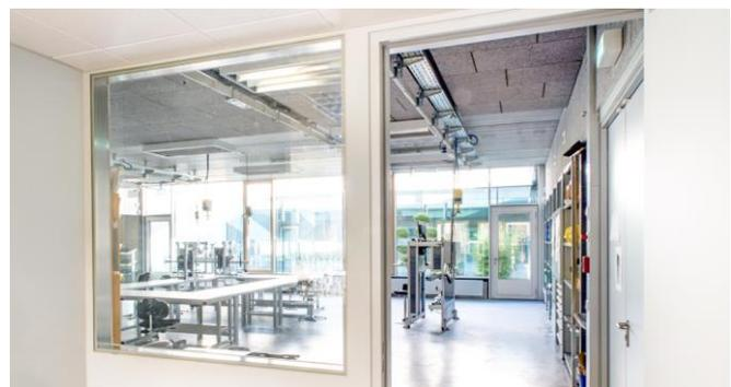
Da psychisch belastete Menschen in der Regel empfindlicher auf Geräusche und Lärm reagieren, wurden in einigen Bereichen der Schallübertragung von einem Raum zum anderen strikte Grenzen gesetzt. Die in den Massivwänden integrierten Glaselemente Planline sorgen mit Werten von  $R_w > 47$  dB für den gewünschten Schallschutz.
