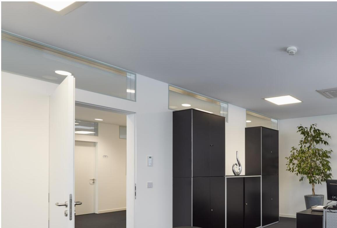
Abb. 1: Oberlichter mit erhöhten Schallschutzeigenschaften: Direkt unter der weißen Decke sorgen sie für maximal mögliche Reflektion des natürlichen Lichts vom Büroraum in den Flur.
