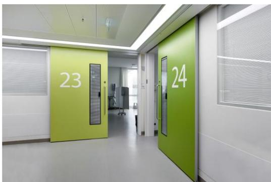
Der Krankenhaus-Innenausbau spezialist Männig Trockenbau GmbH übernahm den Einbau der Planline Fertigfenster. Die rahmenlose, flächenbündige Optik der Trockenbaufenster verleiht zusammen mit der weißen Randemaille nach RAL 9010 ein ästhetisches und hygienisch frisches Äußeres.
