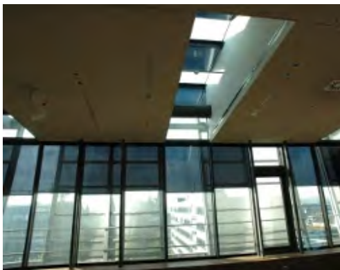
Abb 3 Geneigte Fassadenverglasung mit elektrisch verfahrenbarem ISO-Roll zum Schutz vor Sonne
