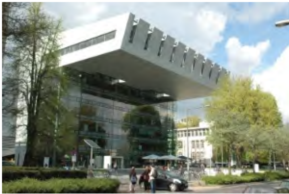
Abb 1 Fassadenansicht SUPER C, Aachen
