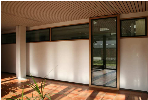
Abb.2 Planline EI30 Brandschutzverglasung schützt Menschen im Falle eines Feuers.
